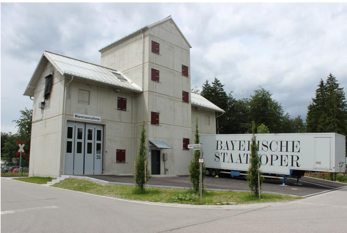
Abbildung 23: Lagerhaus – Markus Weber SFSG
