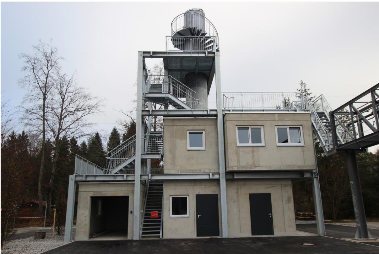
Abbildung 24: Chemieübungsanlage – Markus Weber SFSG
